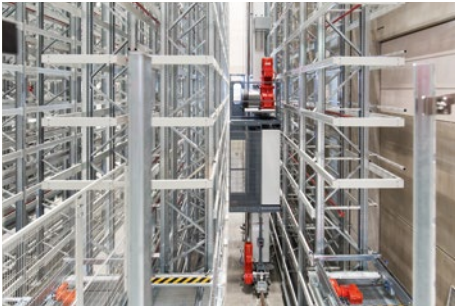
Regalbediengerät Schrägstellungen im Hubwerk von Regalbediengeräten können durch das Softwaremodul verhindert werden.
