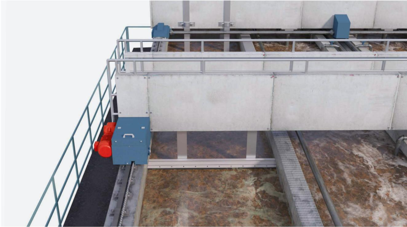
Im Sandfang wird die Fließgeschwindigkeit des Abwassers reduziert, damit sich schwerere Feststoffe wie Sand, Kies oder Erde absetzen können. Diese abgelagerten Partikel werden unter Druck dem Sandklassierer zugeführt. Für
